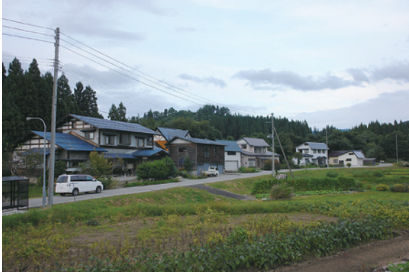
上・雨外地区につながる道路。冬は深い雪に覆われる。このような感じが何kmもつづく。移転後は除雪の回数も減つた。 下・菅生地区にある「もと雨外地区」の住居。一カ所にかたまっている。(撮影・齋藤晋氏)
